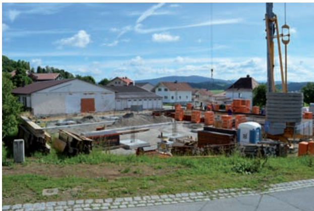
Arbeiten am Fundament
