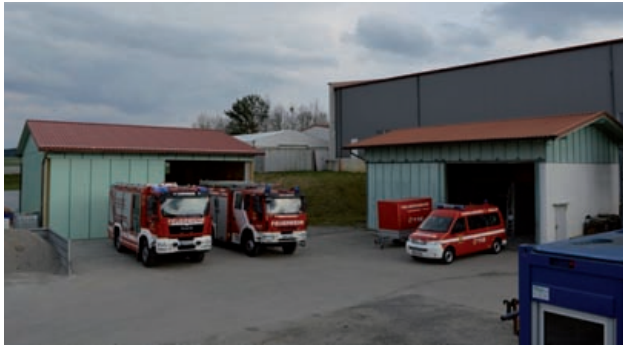
Übergangsquartier am Bauhof
